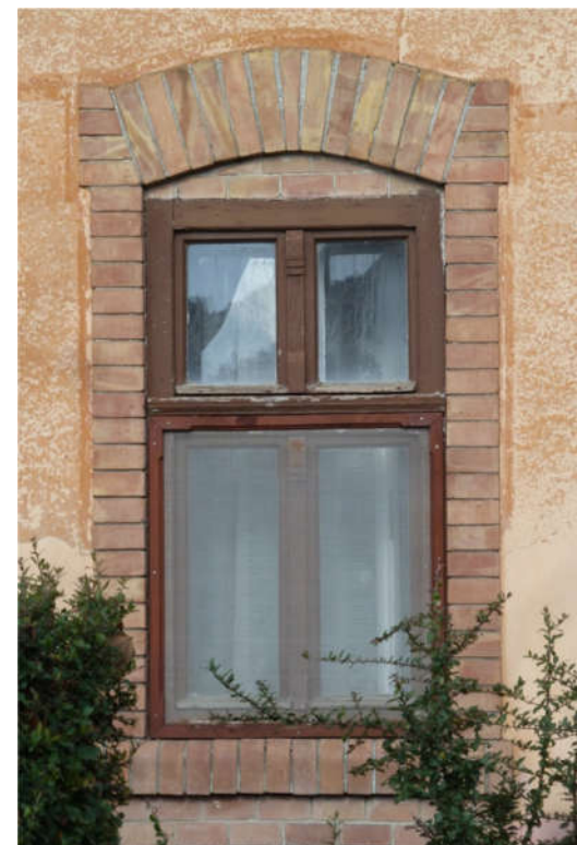
Balra: középen felnyíló szárnyú, felülvilágító ablak. Középen: kifelé és befelé nyíló ablakszárnyakkal rendelkező nyílászáró, nyílászáróval, festett téglapárkánnyal. Jobbra: téglanyílászáróval, alul, felül középen nyílószárnyú ablak.
