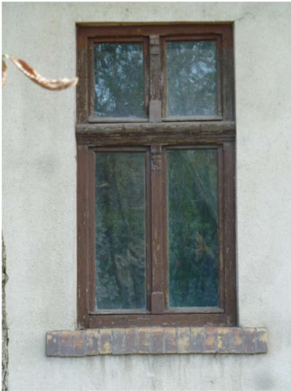
Balra: egyszerű homlokzati felületen díszes, 4 osztott tokos, téglapárkányos ablak. Középen: kifelé és befelé nyíló ablakszárnyakkal rendelkező nyílászáró. Jobbra: vakolt párkányos 4 osztott tokú ablak.
