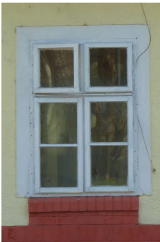
Balra: középen felnyíló szárnyú, felülvilágító ablak. Középen: kifelé és befelé nyíló ablakszárnyakkal rendelkező nyílászáró, nyílászáróval, festett téglapárkánnyal. Jobbra: téglanyílászáróval, alul, felül középen nyílószárnyú ablak.
