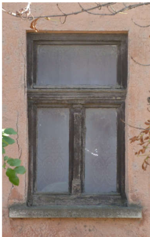
Balra: középen felnyíló szárnyú, felülvilágító ablak. Középen: kifelé és befelé nyíló ablakszárnyakkal rendelkező nyílászáró, nyílászáróval, festett téglapárkánnyal. Jobbra: téglanyílászáróval, alul, felül középen nyílószárnyú ablak.
